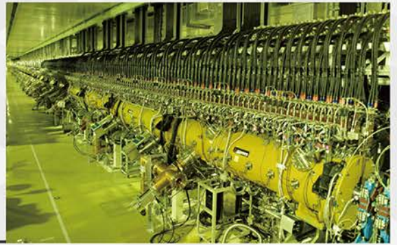
大強度陽子加速器施設 (J-PARC) ドリフトチューブリニアック
