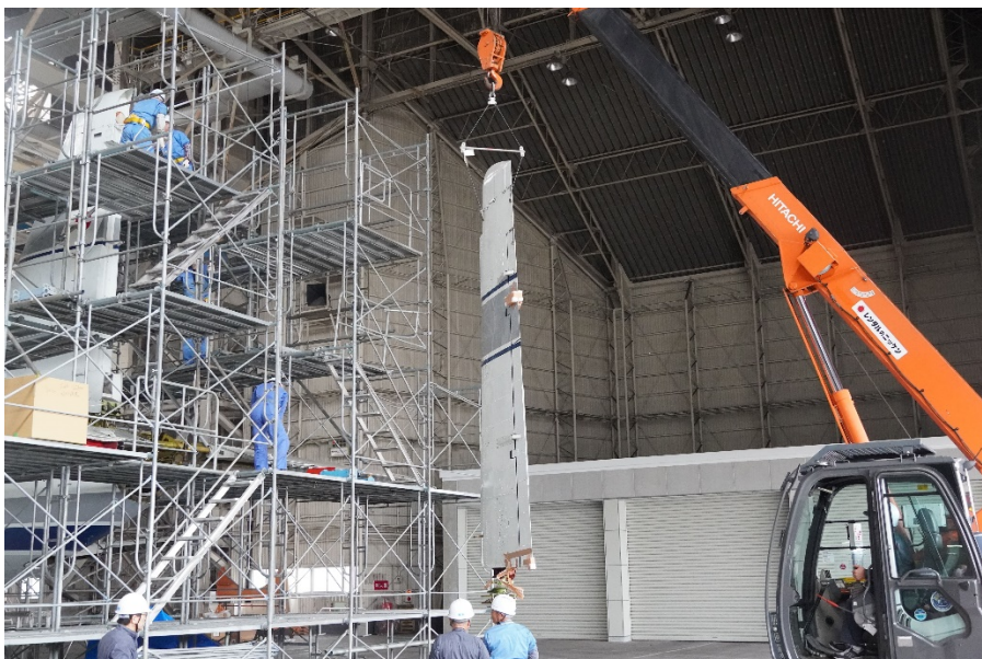
2019/11/25 のラダー取り外し作業
