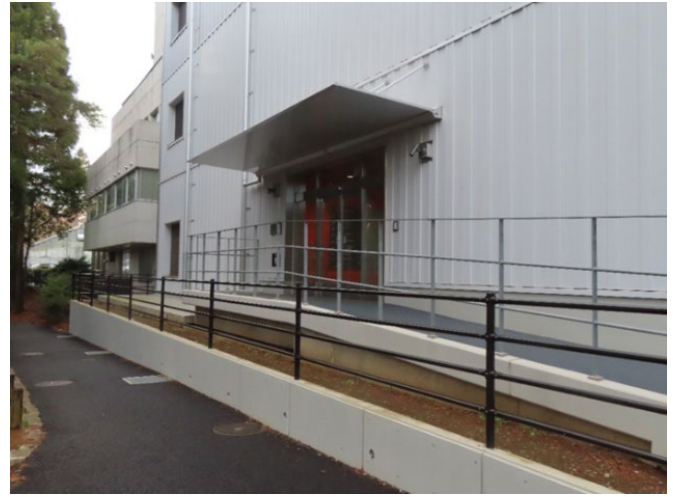
標本・資料棟 1階見学スペース入口外観
