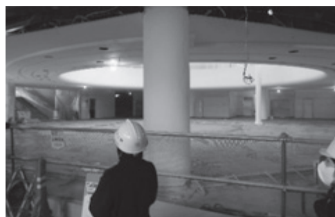
工事中の国立スポーツ博物館
