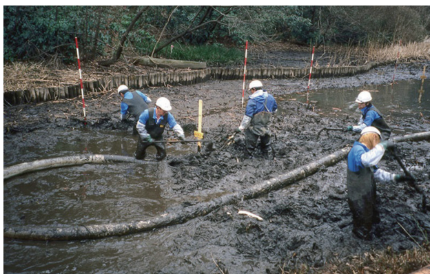
図2 水生植物園における浚渫（2004年）。
