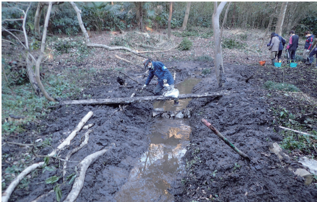
図1. 2021年12月 新水路試掘の様子。
