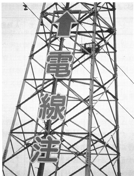
図1 高圧送電線鉄塔に造られたカラスの巣
