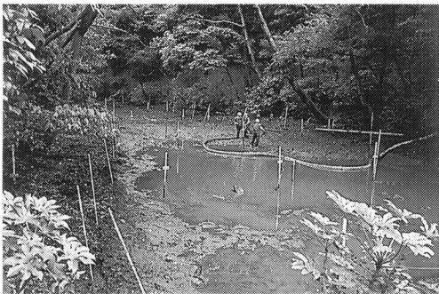
図7 水鳥の沼の浚渫工事 (2004年5月)
