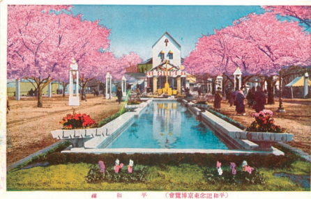
01 【(平和記念東京博覧会) 平和館】 本博覧会のテーマである「平和」の象徴として作られ、映画・講演・コンサートの会場として使われた。正面の「甍」(切妻部分)に平和の鐘をつるして鳴らし、入り口の両側には新海竹太郎の手になる「平和の女神像」が設置された。現在の竹の台広場の、噴水のあたりに建設された 8) 。
