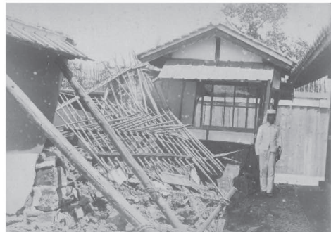
(h) 熊本監獄内土塀崩壊
