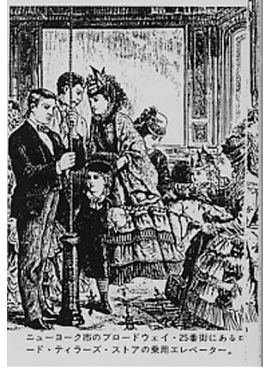
図13. ロープコントロールの運転の様子
