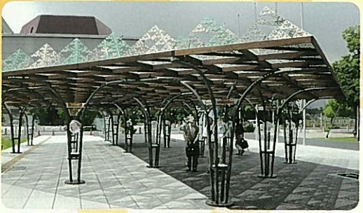
●自然の樹木と同じ機能をもち、フラクタル構造をデザインした日よけの一部です。
