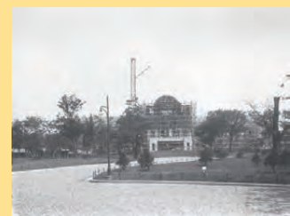
建設中の日本館の写真(昭和4年) A photograph of Japan Gallery under construction in 1929
